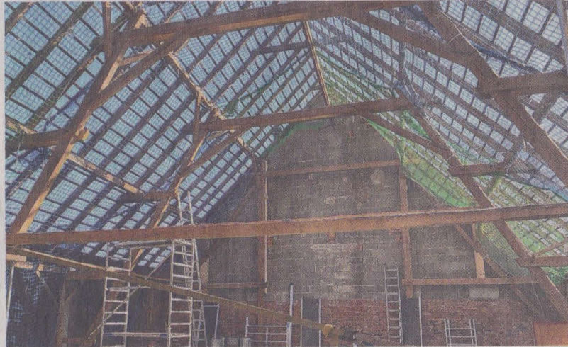
Saniert wird derzeit das alte Hofhaus in Weicht. Unser Foto zeigt den offenen Dachstuhl des Gebäudes, das „Artists for Kids“ nutzt.
