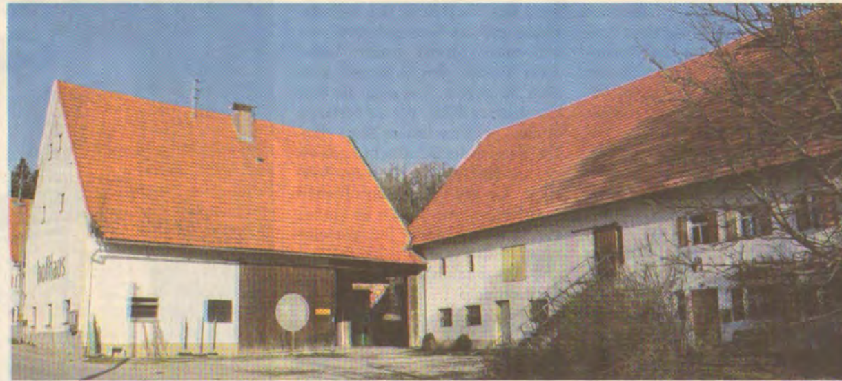
Frühestens ab Sommer 2012 soll wieder Leben in das ehemalige Hofhaus in Weicht einziehen. Bis dahin will der neue Eigentümer, die Gesellschaft „Artists for Kids“, das Gebäude modernisieren. Foto: Claudia Goetting
